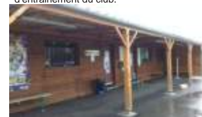
3. Le bâtiment est un bâtiment préfabriqué avec parement bois utilisé par le club en buvette et bureaux.
