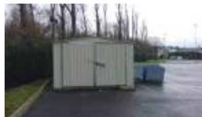
5. Le bâtiment est un abri métallique, utilisé pour le stockage du club.
