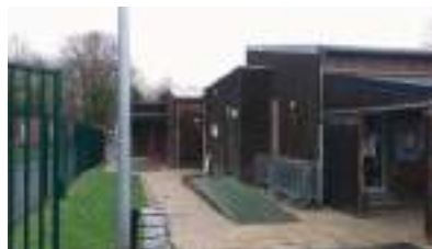
1. Le bâtiment est un bâtiment préfabriqué avec parement bois utilisé en bâtiment vestiaires pour le club.
