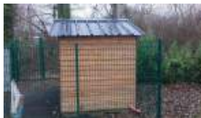
6. Le bâtiment est un abri en bois de type abri de jardin, utilisé en guichet d'accueil du public visiteur.
