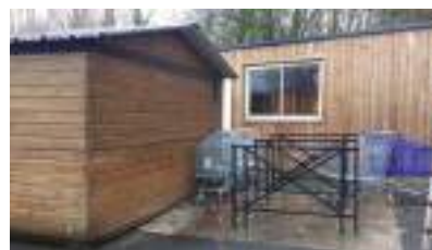
2b. Le bâtiment est un abri en bois de type abri de jardin, utilisé en guichet d'accueil du public.
