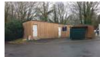
2.a. Le bâtiment est un bâtiment préfabriqué avec parement bois utilisé pour le stockage du matériel d'entraînement du club.
